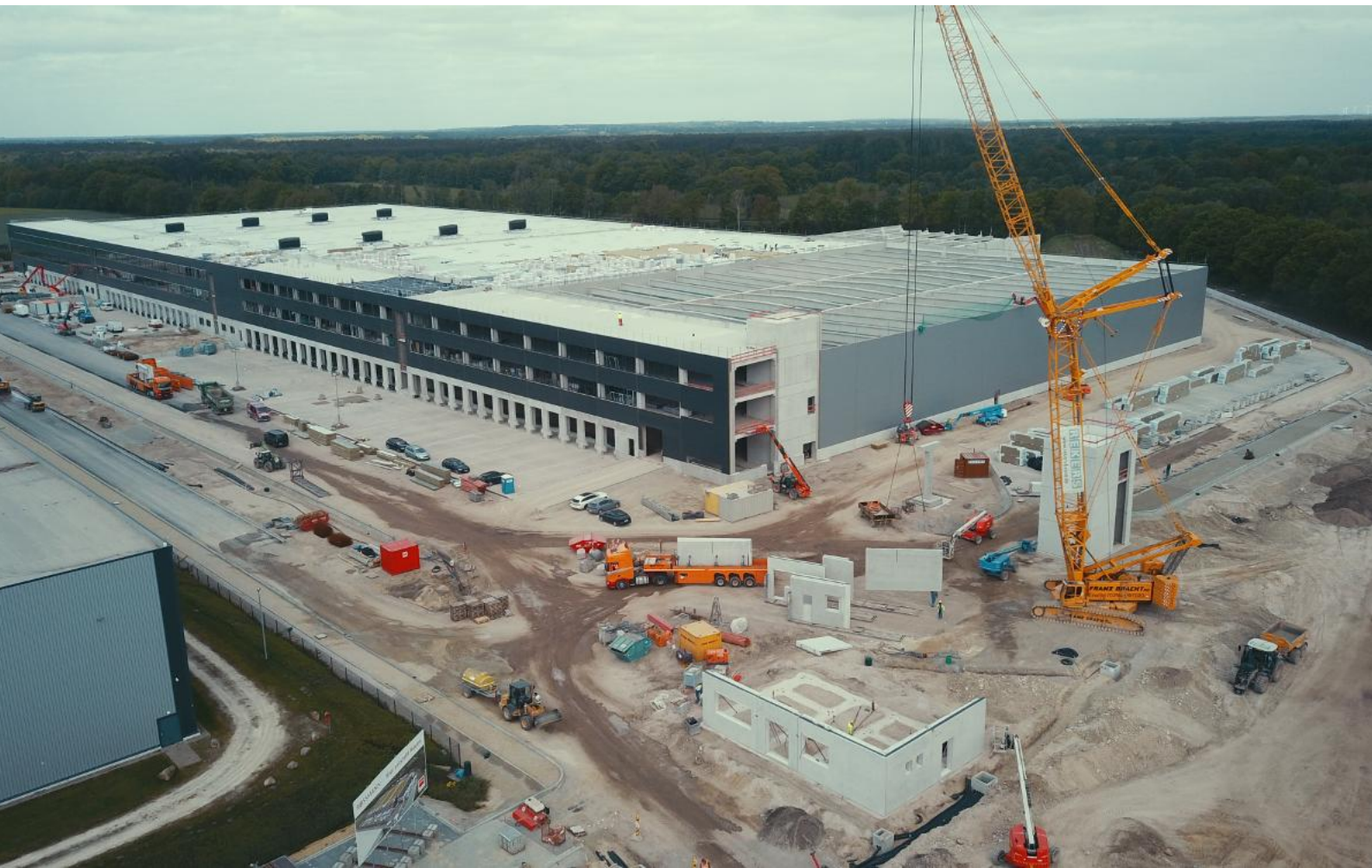
Bild: Rekers Betonwerk GmbH & Co. KG | Fertigteilbaustelle Logistikzentrum in Burgwedel
