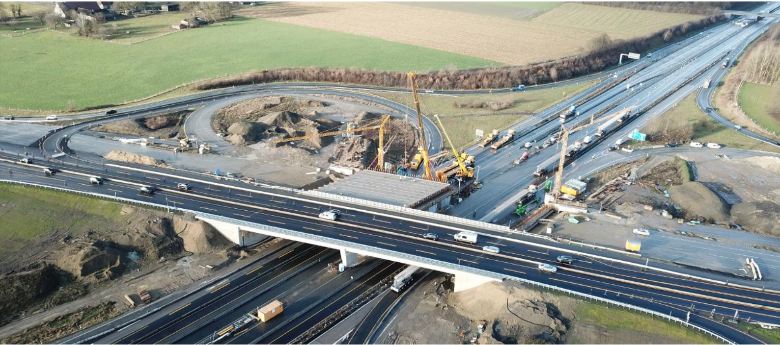
Bild: Rekera Betonwerk GmbH & Co. KG | Brückenbauwerk A1/A30
