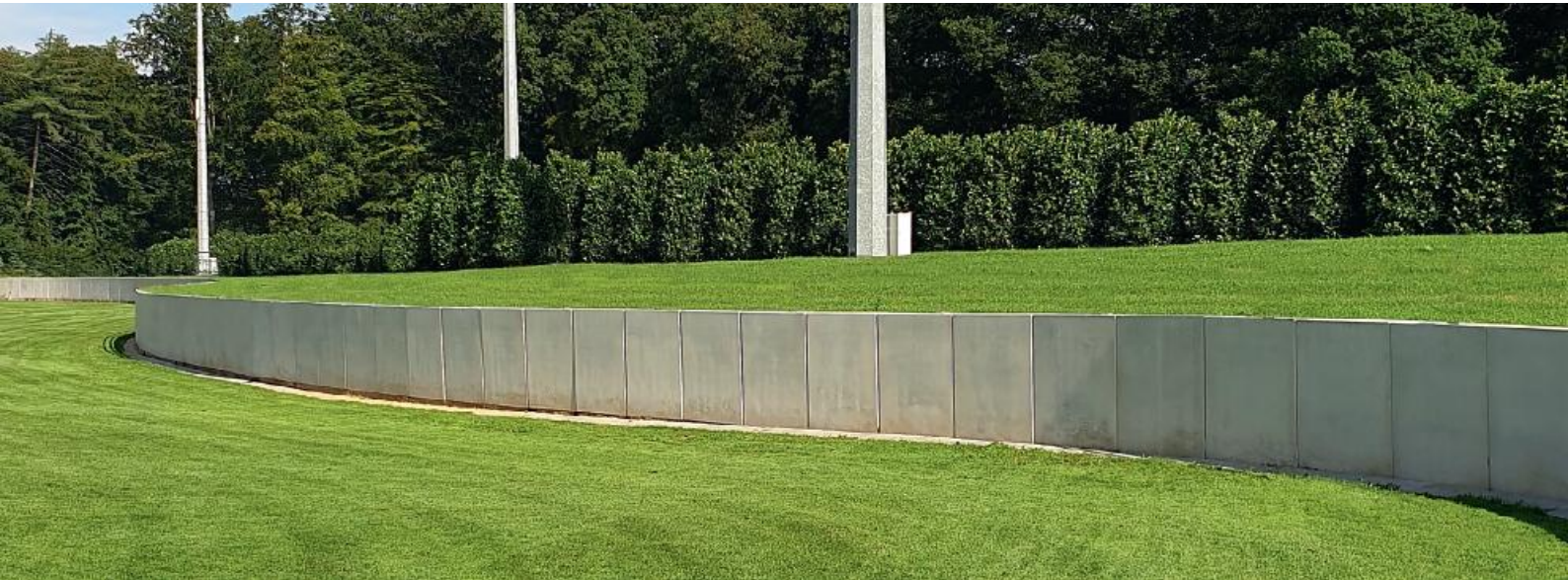
Bild: Rekers Betonwerk GmbH & Co. KG | GaLa Baustelle
